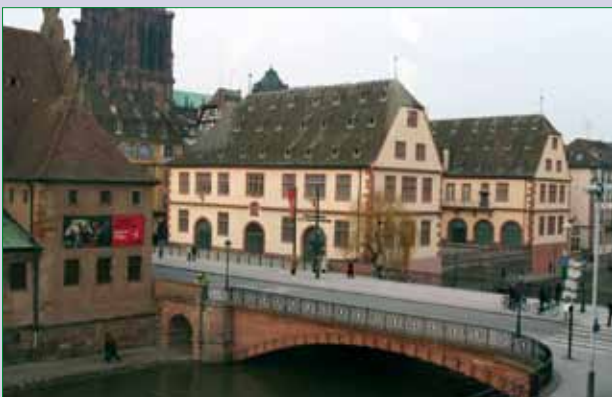
Ein Stadtmobiliar aus finsternen Zeiten : die von Richard Beblo 1942 umgestaltete Rabenbrücke, bereinigt von der Ziertürmchen aus der Wilhelminischen Zeit. Der Blick ist frei auf das Münster, das Juwel der «Wunderschönen Stadt». (Archistrasbourg, Fabien Romary)
