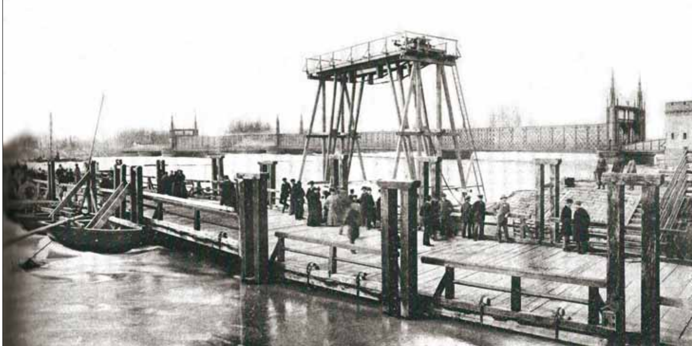
Rund acht Jahrzehnte lang verband seit 1816 diese Schiffbrücke Straßburg mit Kehl.
