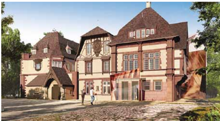
Le projet de restructuration du domaine de la Léonardsau, située à Boersch, est prévu pour 2024.
