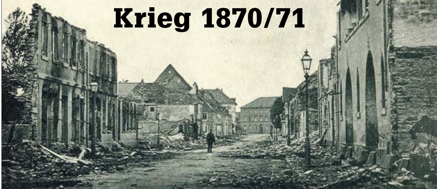
Zerstörte kehler Hauptstraße.
