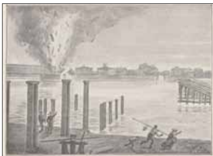
Les Badois font sauter le tablier mobile du pont de chemin de fer à Kehl.
